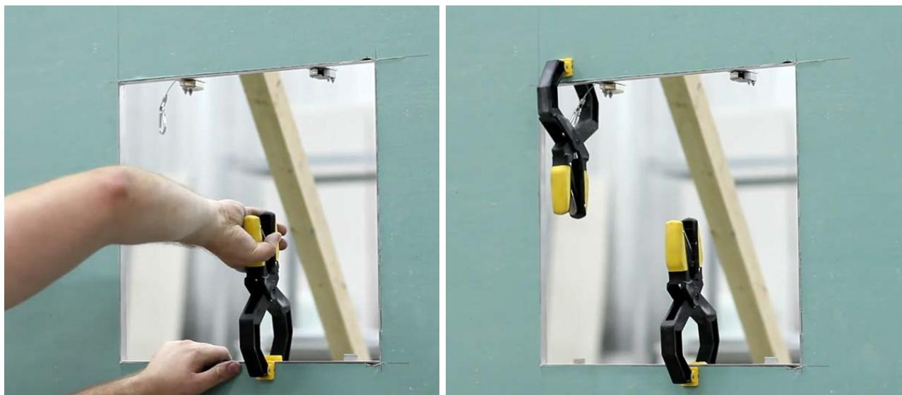
7. Сверлим СКВОЗНЫЕ отверстия по внешней стороне гипсокартона через раму для крепления по периметру проема на расстоянии 10-15 см от углов.
